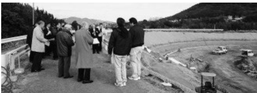
県営ため池耐震化整備事業（山下池）
