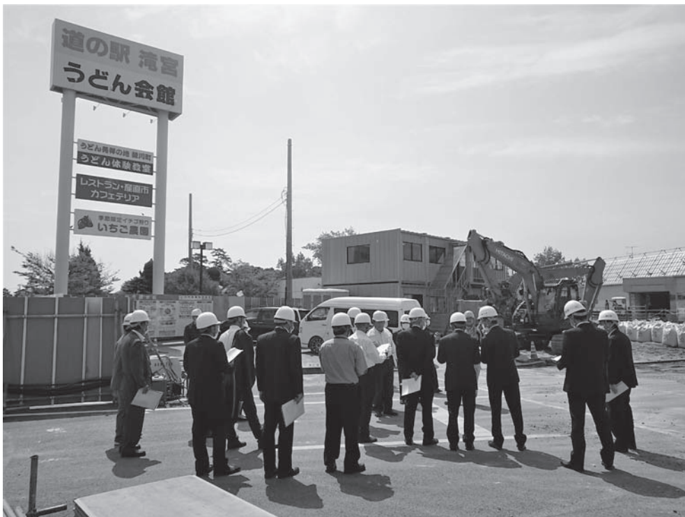
「道の駅滝宮」リニューアル工事の進捗状況を視察
