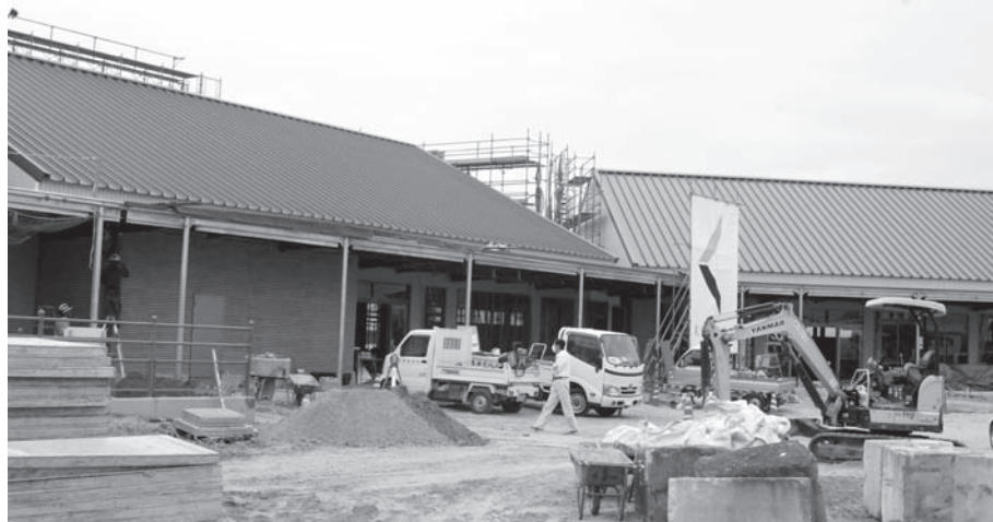
オープンに向けて工事中の道の駅滝宮・うどん会館
