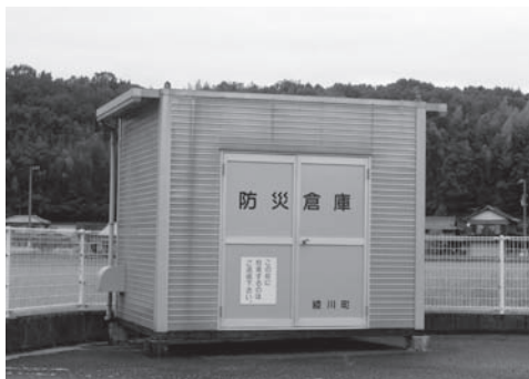
現在設置されている防災倉庫
