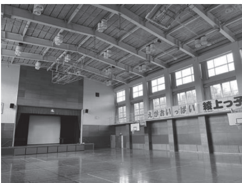
綾上小学校体育館
